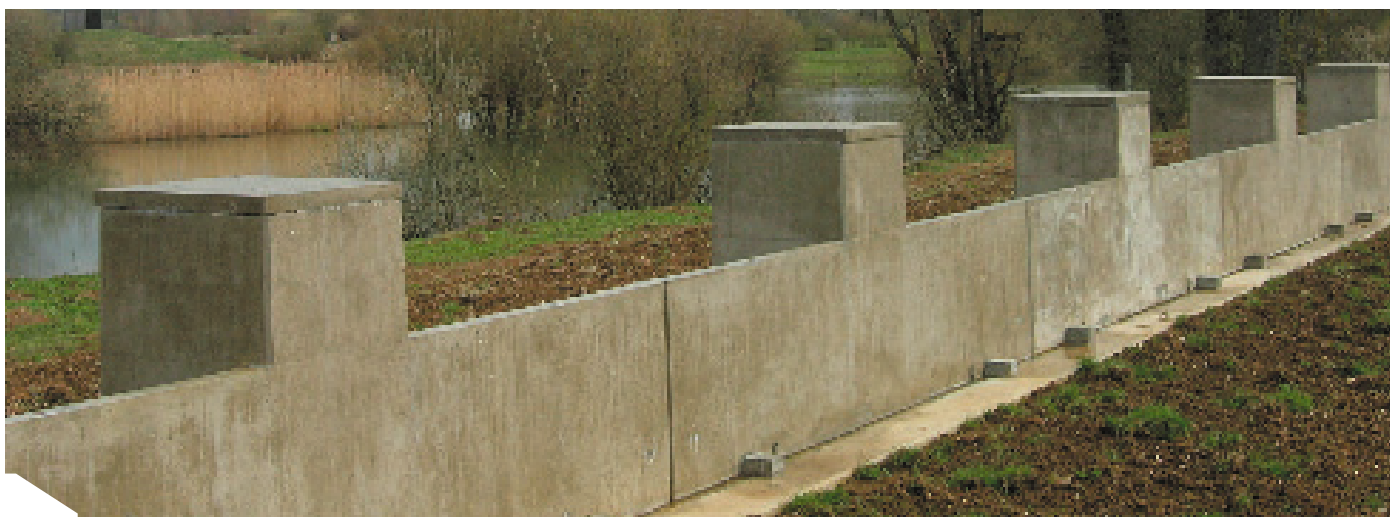
Déversoir équipé de hausses fusibles à la fin des travaux en novembre 2007
