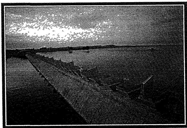
Fig. 2 Barrage de Sonmati équipé de hausses fusibles Sonmati dam equipped with fusegates
