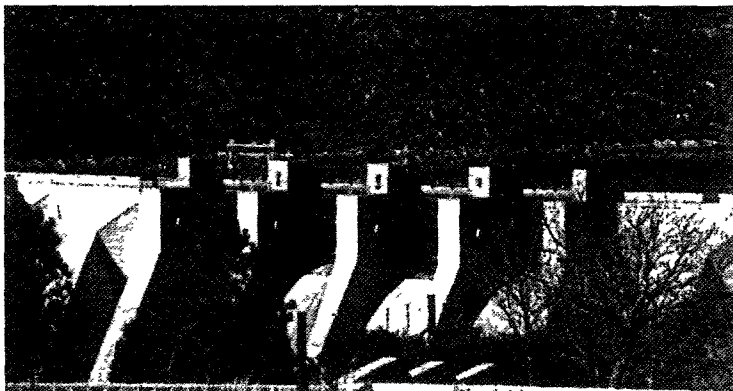
Fig. 1 Witbank dam spillway (South Africa) Évacuateur de crue du barrage de Witbank (Afrique du Sud)
