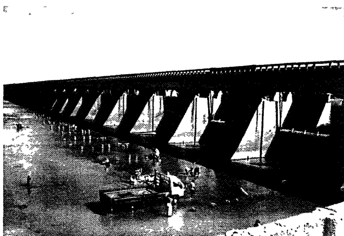
Fig. 3 Washing, etc, downstream of a spillway Lessive, etc, en aval d'un évacuateur de crue
